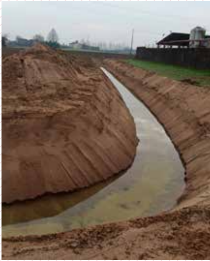
Scavo di nuovo fossato meandriforme a pendenza costante
