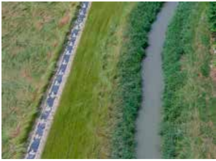
Realizzazione di fascia tampone con telo pacciamante e fascia inerbita contigua al corso d'acqua
