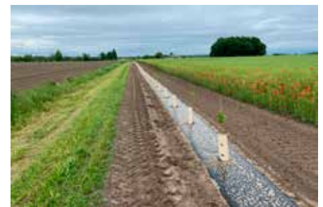
Realizzazione di fascia tampone con telo pacciamante e fascia di rispetto contigua al corso d'acqua
