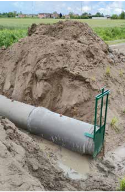
Scavo e posa dei manufatti di collegamento idraulico
