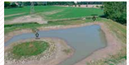
Particolari delle tubazioni di ingresso e uscita da un'area umida
