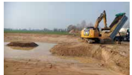
Operazioni di scavo per creazione di un'area umida
